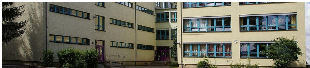
Abbildung 4: Grundschule Ueckertal Pasewalk
